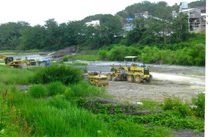
▲尾張旭上流(矢田川)工事
